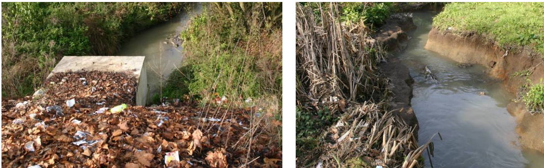
Figura 1 – Exemplo do estado de actual de degradação da Ribeiras do Porto.
